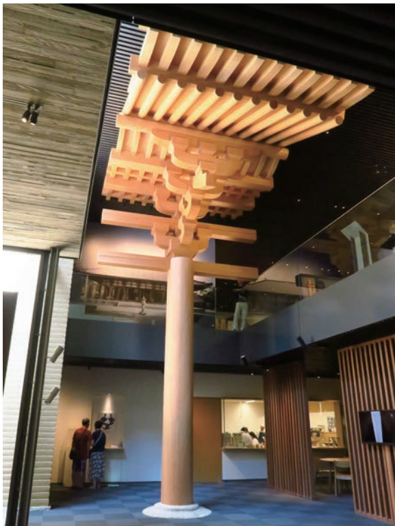
仿製招提寺金堂的全尺寸樑柱斗拱模型。
