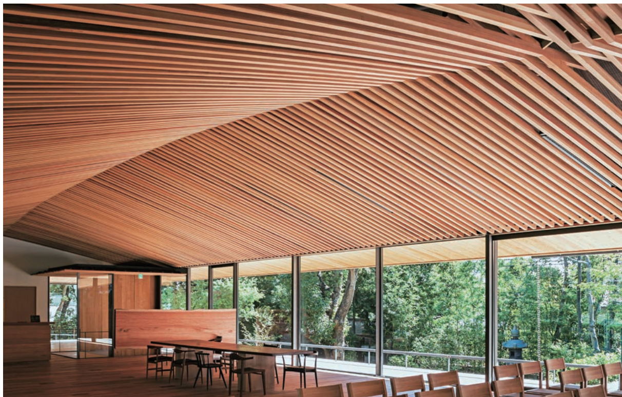
一樓大廳以傳統技法榫接杉木柱，構成巨大又優美的舟狀天花。
