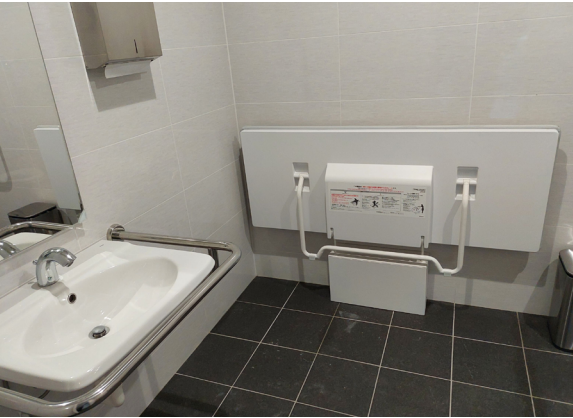
圖 2 多功能洗手間內除了設置扶手外也設置照護枱 （圖片來源／劉少君拍攝）
