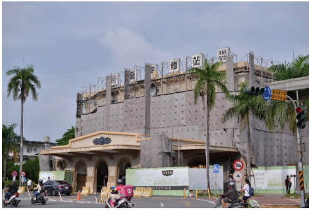
圖 3 臺南火車站修繕工程（蔡侑樺 2021 年攝）。
