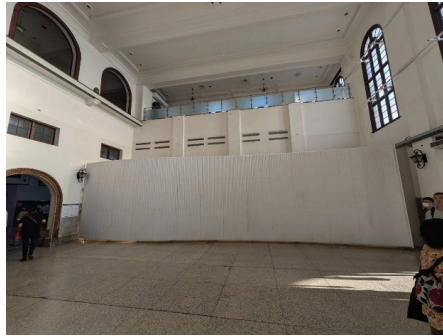
圖 6 臺南火車站修繕工程之施工圍籬（蔡侑樺 2024 年攝）。
