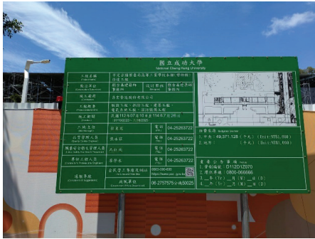
圖 5 成大博物館修繕工程告示牌（蔡侑樺 2024 年攝）。
