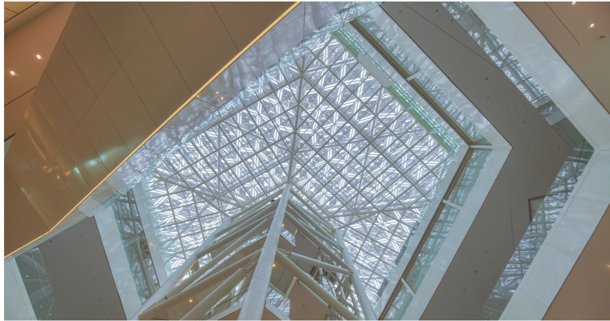
由南美館大廳仰視五角形結構碎形屋頂，大面積引進自然日照。
