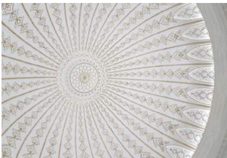
圖 6 博物館屋頂內部
