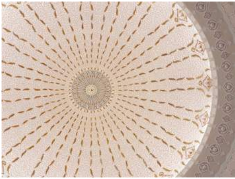
圖 5 博物館屋頂內部
