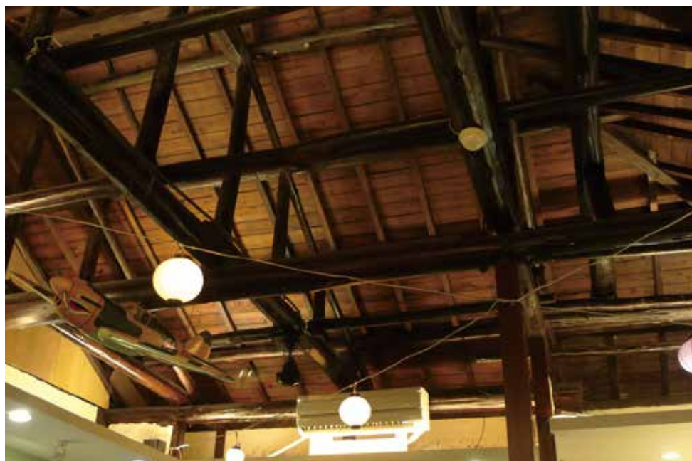
圖 4 建築內部木造結構的呈現創造民眾與歷史建築之間溝通的場域
