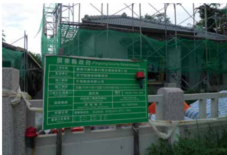
圖 1 屏東市勝利眷村歷史建築修復工程
