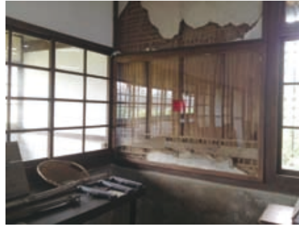
圖3 嘉義市舊監仍保存九十多年的木板牆壁
