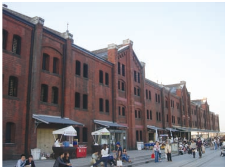
圖7 紅磚倉庫 2 號館所營造的觀光休憩據點
