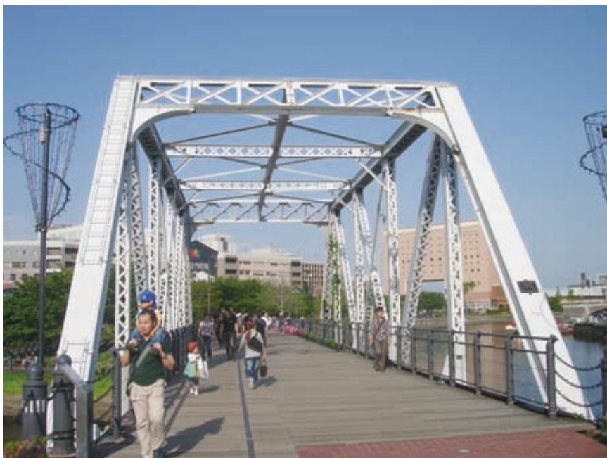
圖5 舊臨港線橋梁群與鐵道意象復元所營造之人行步道
