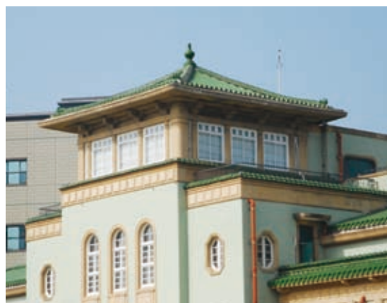
圖12 中央塔樓現貌
