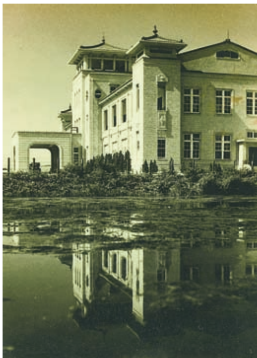
圖1 日治時期初建完成外觀 高雄市役所初建完成之景，市役所座北朝南，位於高雄川西畔的鹽埕區榮町，代表對港口發展和水運交通的重視。此照片攝於西元1939年（日本昭和14年）。（照片提供：高雄市立歷史博物館數位典藏）
