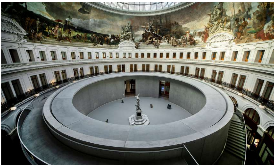
「證券交易所 (皮諾私人美術館)」，將新與舊的對話作為設計的主題。在歷史悠久的建築物中，插入一個高 10 公尺，直徑 30 公尺的混凝土圓筒形空間，從而形成一個大膽的套筒狀空間結構。 (圖片來源／ Yuji ONO)
